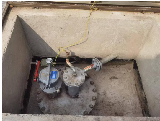
油罐区一侧水位观测井
