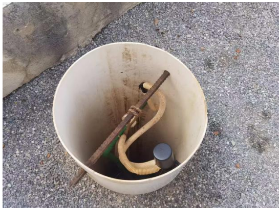
油罐区一侧水位观测井
