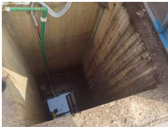
油罐区一侧水位观测井
