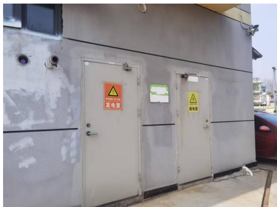
发电机排烟管口阻火器
